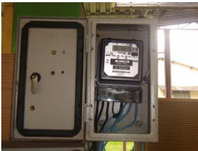
Figura 26 – Medidor digital de energia elétrica.
