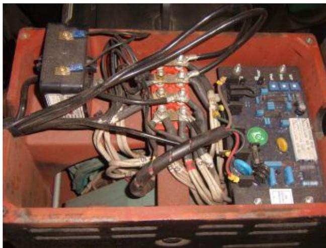
Figura 29 – Ligação dos bornes do gerador ao painel de comando e proteção.
