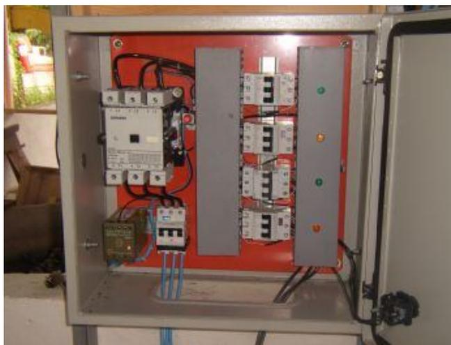
Figura 20 – Quadro de comando e proteção.
