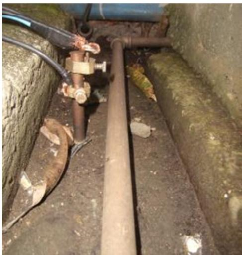
Figura 25 – Eletrodo de aterramento.
