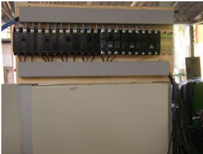
Figura 24 – Pannel de disjuntores tripolares.
