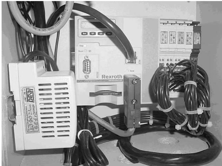
Figura 16: Detalhes da montagem final do CLP Indracontrol
