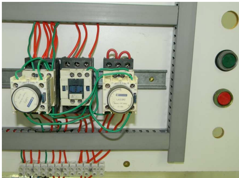
Figura 12: Painel Estrela-Triângulo.
