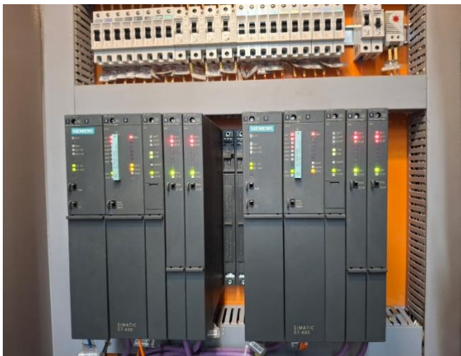
Fig. 3. Par de CPUs redundantes.
