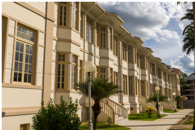
Fig. 2. Foto da fachada principal do edifício Bello Lisboa. Fonte: Divulgação Institucional UFV.
