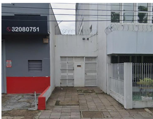
Figura 20 – Entrada lateral existente – Fonte: Google Street View
