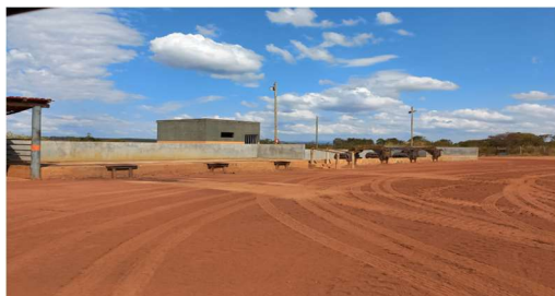
Figura 4 – Área destinada a construção da cobertura Fonte: Autor próprio
