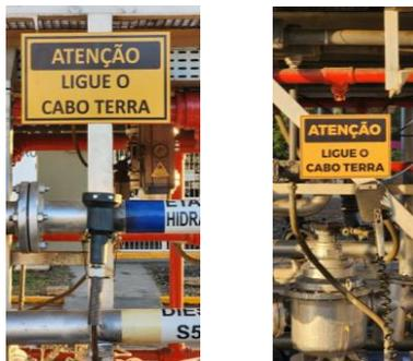
Figura 7. Aterramentos modalidade *bottom* e *top loading*
