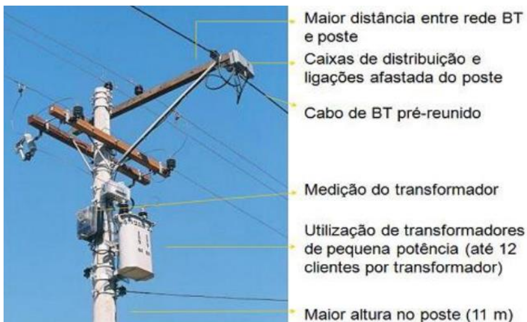
Figura 35 - Configuração da Rede DAT (FONTE: ABEPRO)
