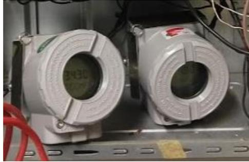
Figura 15 - Componentes da rede H1, TT302 (esquerda) e FI302 (direita).
