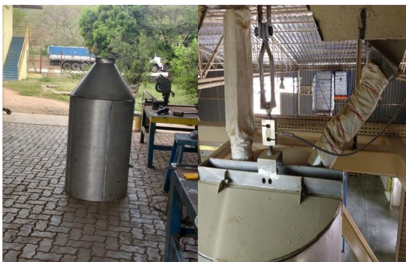
Figura 32 - Troca do Silo Pulmão de Fubá e Implantação do Modulo de Pesagem (Acervo do Autor).
