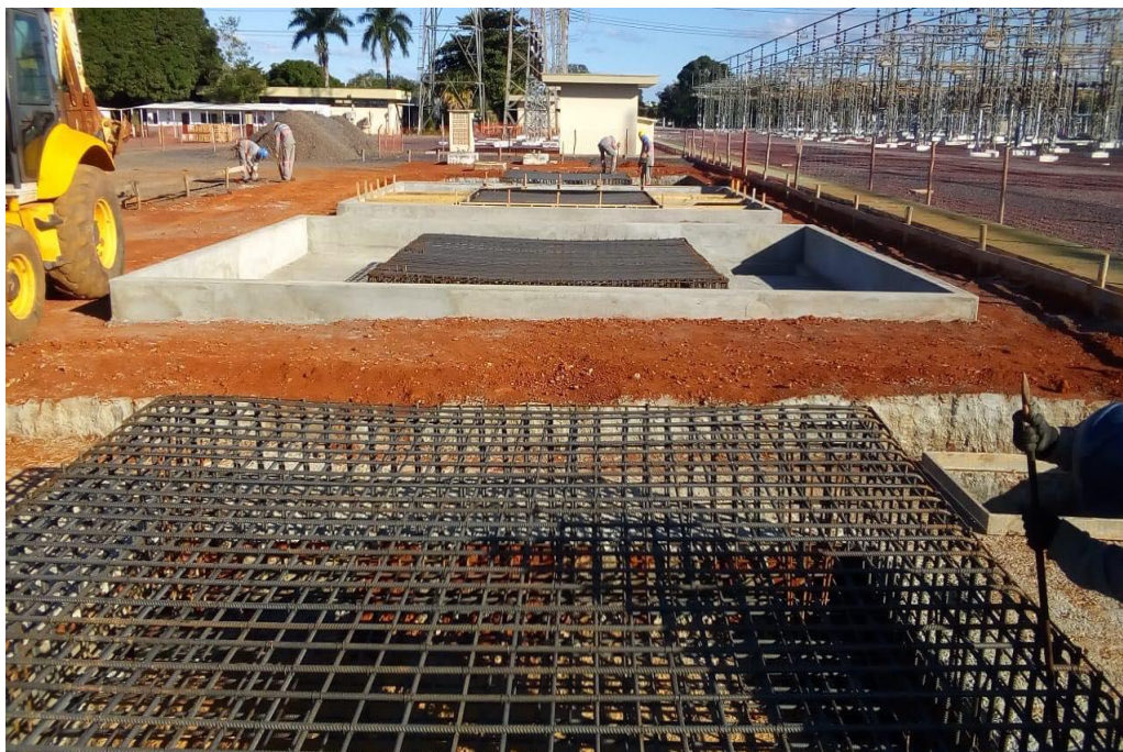
Figura 22 – Fundação dos Banco de Transformadores SE Pimenta 345/138 kV
