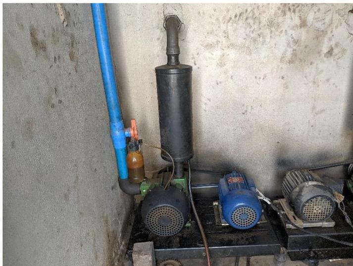
Figura 25 - Bomba de vácuo e motor elétrico monofásico.
