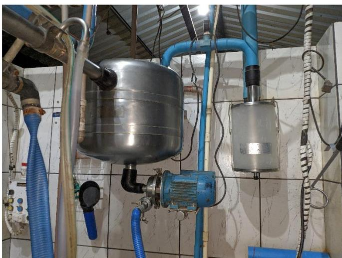
Figura 24 - Recipiente de coleta, bomba de leite, barreira sanitária (a direita) e manômetro (em cima).
