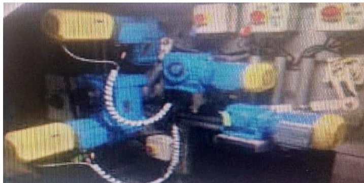
Figura 23 - Revitalização da pintura dos redutores na mesa de entrada.
