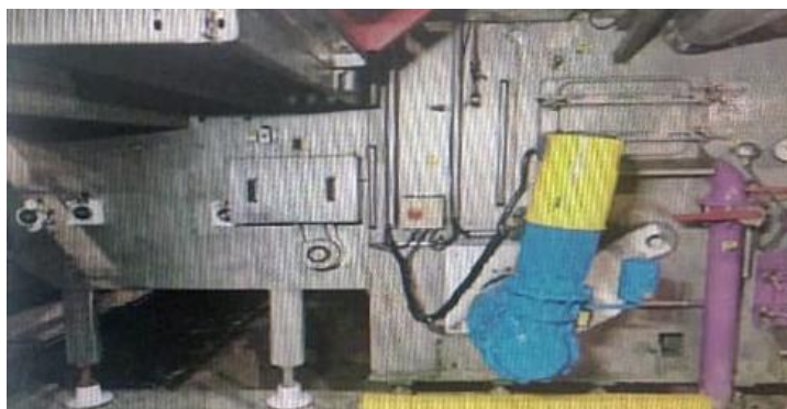
Figura 24 - Lateral da LGV depois da pintura e instalação de refletores
