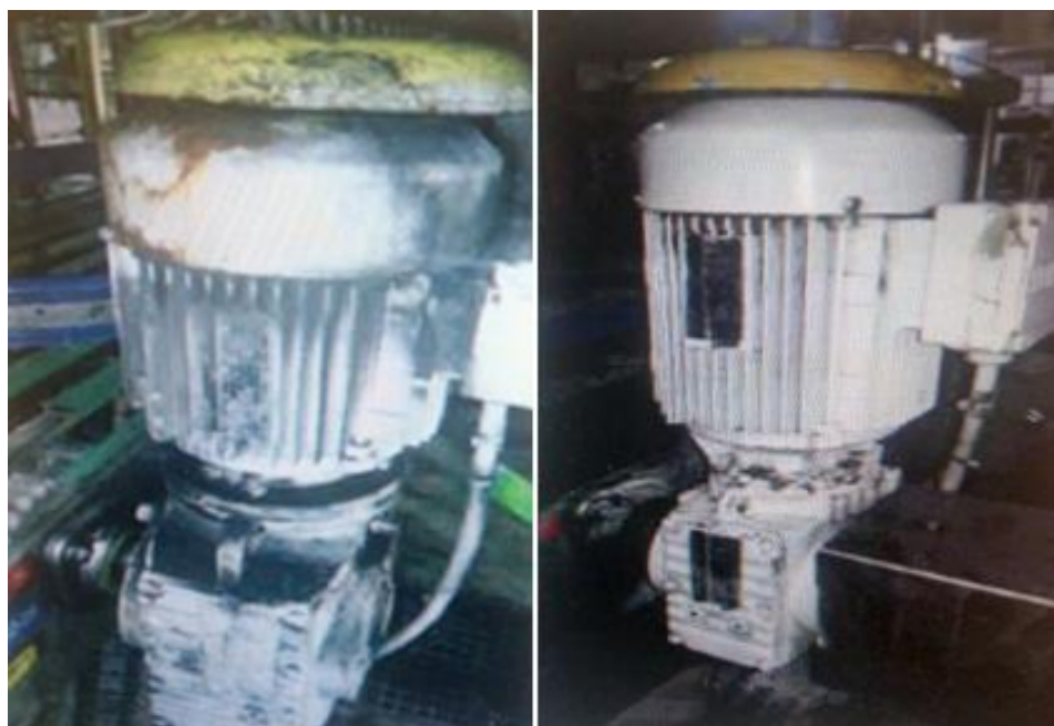
Figura 14 - Motoredutor da esteira na mesa de saída. Antes e depois do Dia D.
