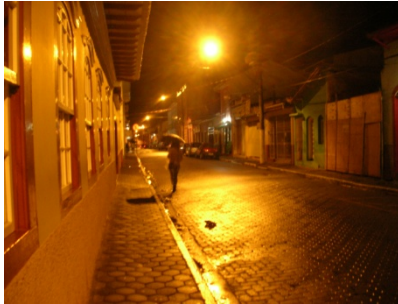
Figura 26 - Iluminação original com lâmpadas de vapor de sódio.
