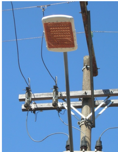
Figura 25 - Luminária pública de LED com filtro para modificar a temperatura da cor da luz.
