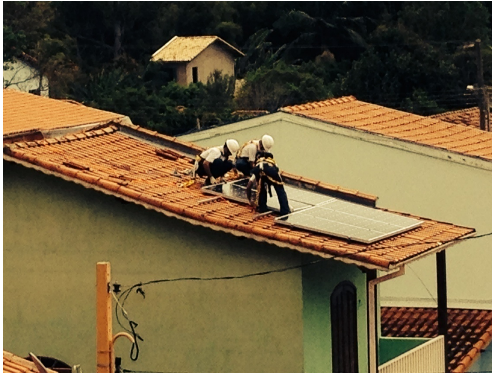
Figura 11 - Funcionários da distribuidora instalando painéis fotovoltaicos na residência da cidade.
