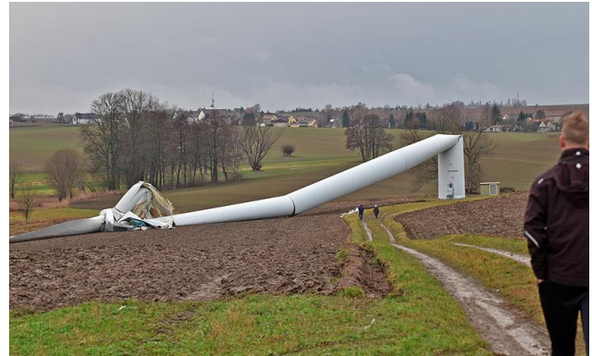
Figura 13: Queda de turbina eólica na Alemanha, 2017. O impacto fez com que partes da turbina penetrassem mais de 2 metros no chão.
