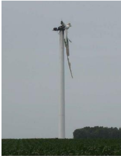
Figura 14: Turbina eólica destruída por raio em Minnesota, EUA.
