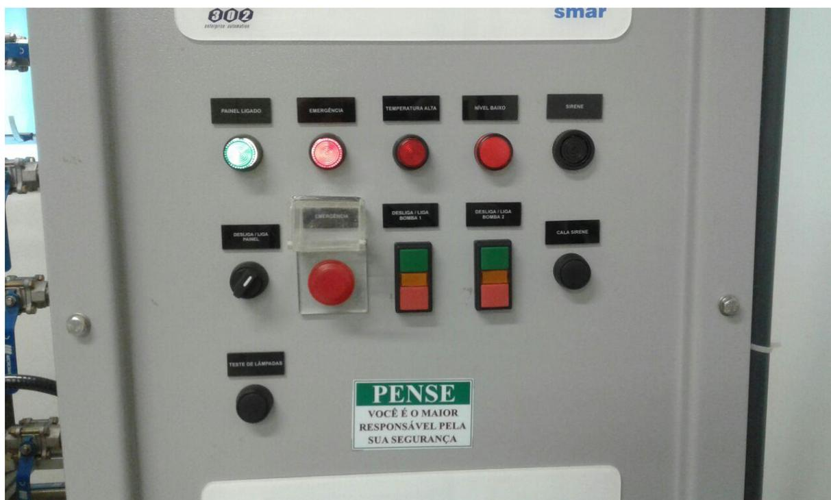
Figura 29 - Sinaleiro emergência no painel.
