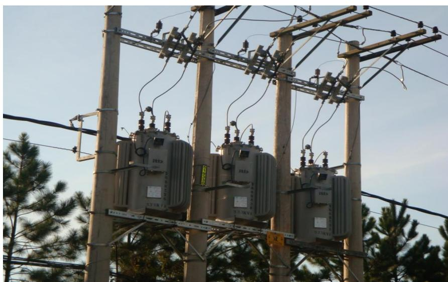
Figura 7. Exemplo de banco de reguladores de tensão nos postes de distribuição.
