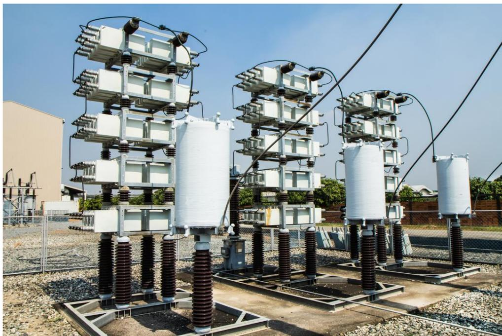
Figura 6. Exemplo de banco de capacitores semi-automático em tensão primária de distribuição.
