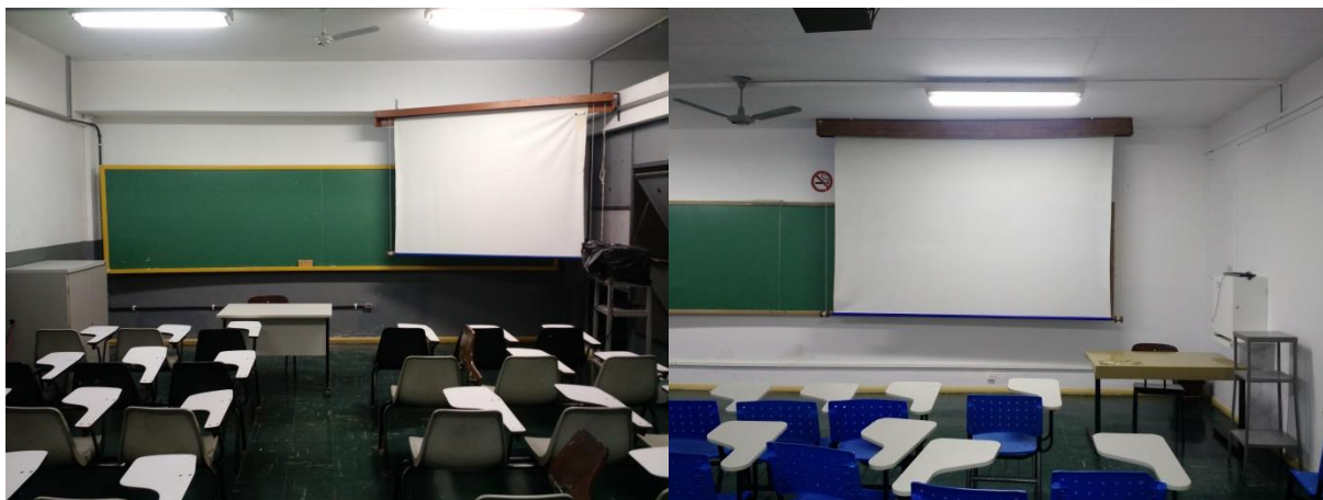
Figura 8 – Sala PVA 134 à esquerda com lâmpadas fluorescentes, sala PVA 223 à direita com lâmpadas LED, ambas bem iluminadas apesar do maior volume a iluminar na sala 223
