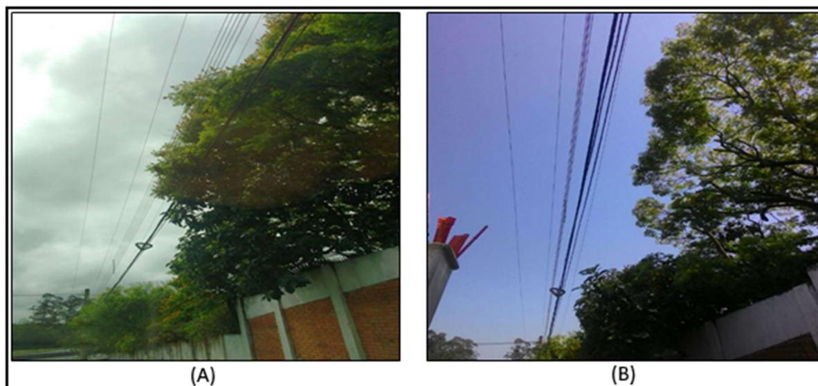
Figura 17 - (A) Árvore em espaço privado crescendo em direção a rede primária (B) Árvore após a poda. Fonte: Acervo do Autor.
