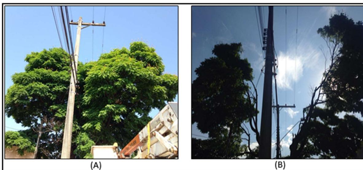
Figura 18 - (A)Árvore em espaço público entorno do condutor primário (B)Árvore após a poda em formato de V. Fonte: Acervo do Autor.
