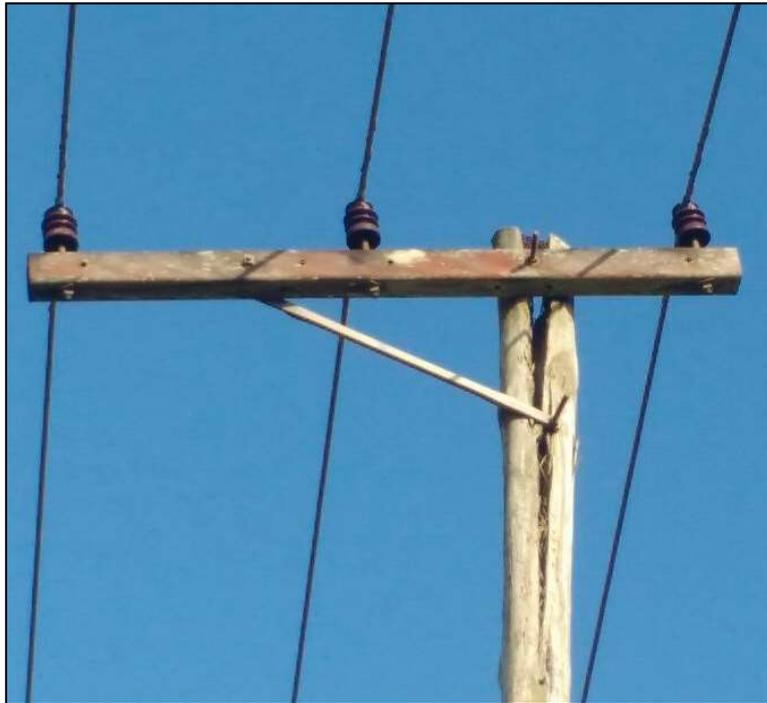
Figura 23 - Poste de madeira com rachadura na ponta do poste. Fonte: Acervo do Autor.
