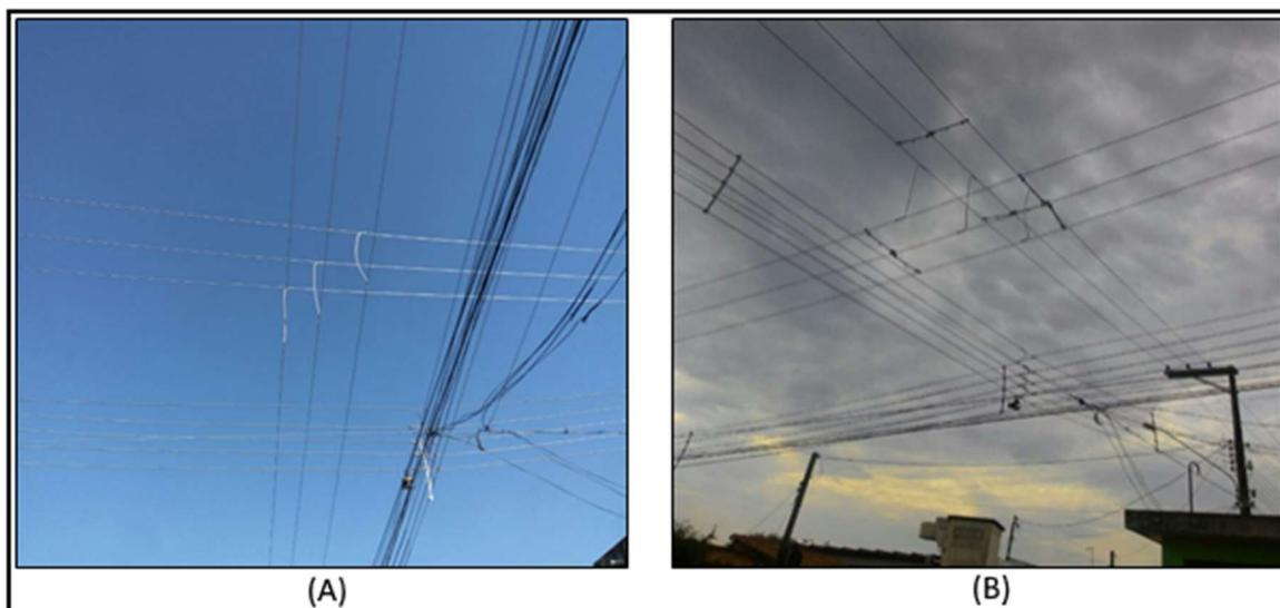
Figura 16 - (A) Derivação sem espaçadores (B) Derivação após instalação de espaçadores. Fonte: Acervo do Autor.
