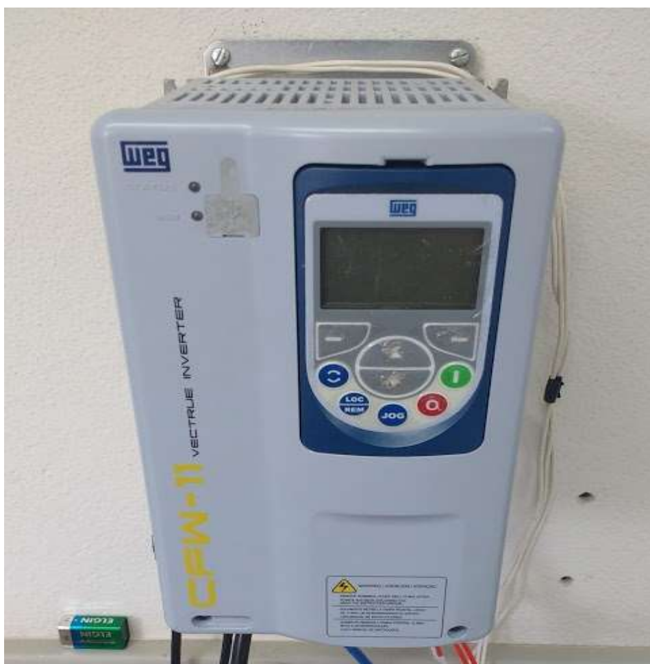
Figura 10 - Inversor de frequência.
