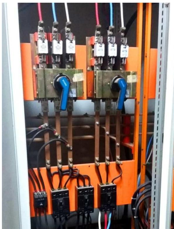
**Figura 12 - Barramento de saída do transformador**
