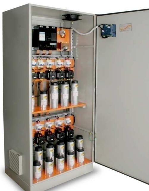
**Figura 7 - Banco de capacitores automático (TLA)**
