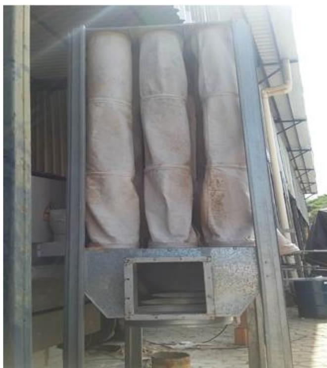
Figura 25 – Filtros mangas com as mangas desgastadas.
