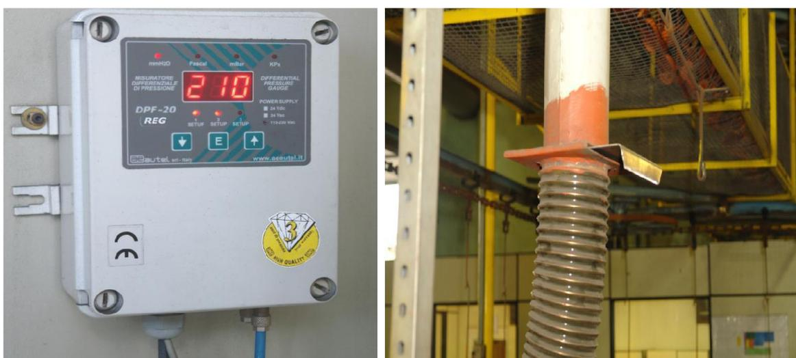
Figura 23 - Instalação do regulador de pressão e de *dampers* no sistema de exaustão.
