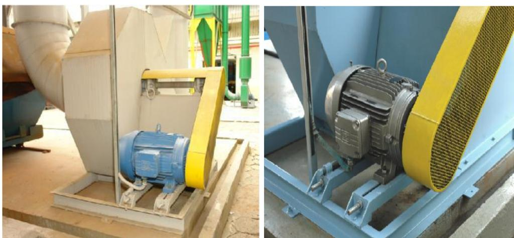
Figura 22 - À esquerda, motor de indução, usual em sistemas de exaustão e à direita, motor *Wmagnet* com acionamento de inversor de frequência.
