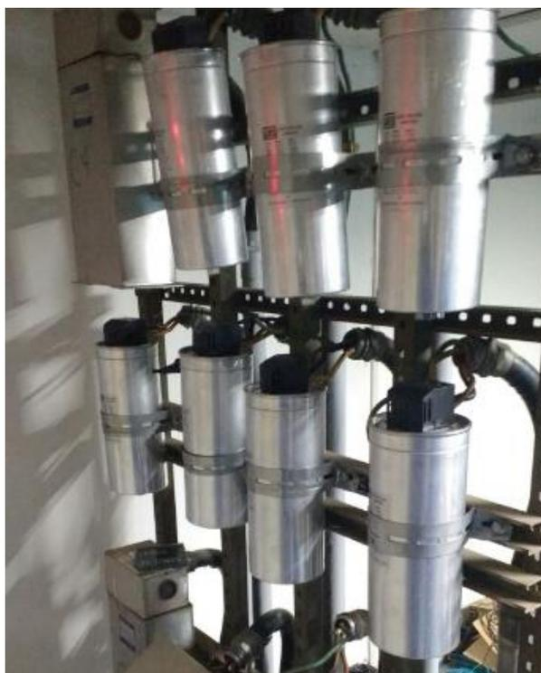
**Figura 23: Capacitores substituídos nos bancos**
