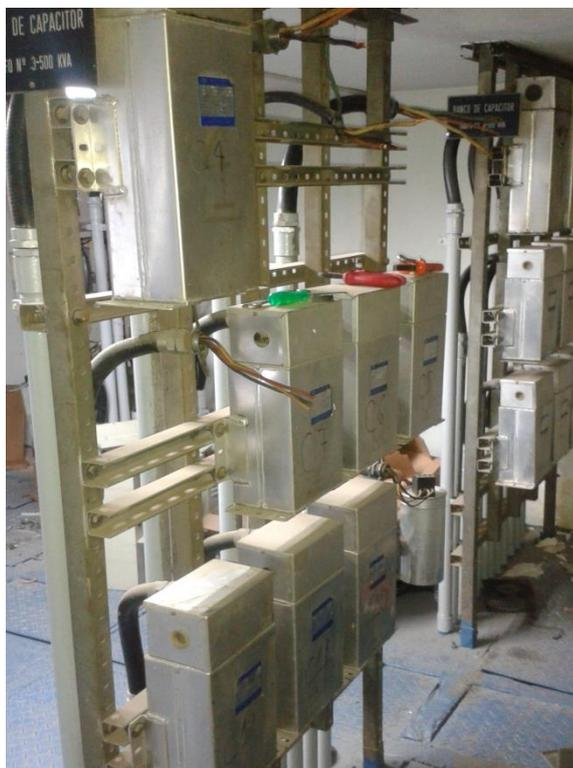
**Figura 11: Inspeção dos BC e retirada dos capacitores defeituosos**
