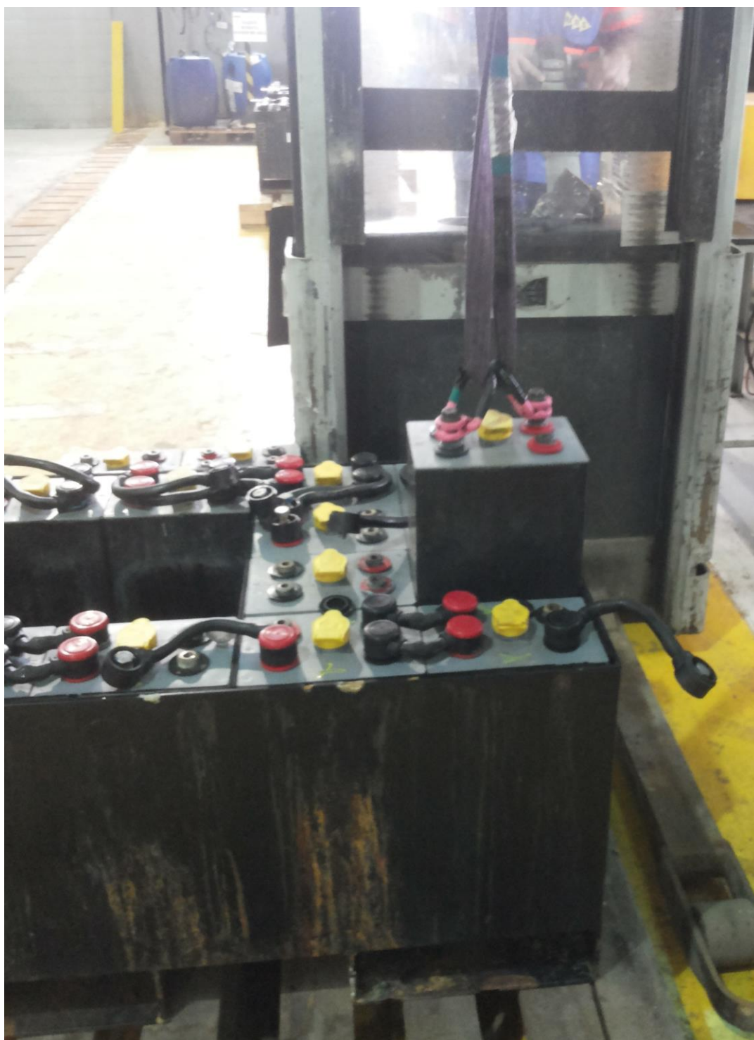
Figura 8 - Troca dos elementos utilizando a palleteira
