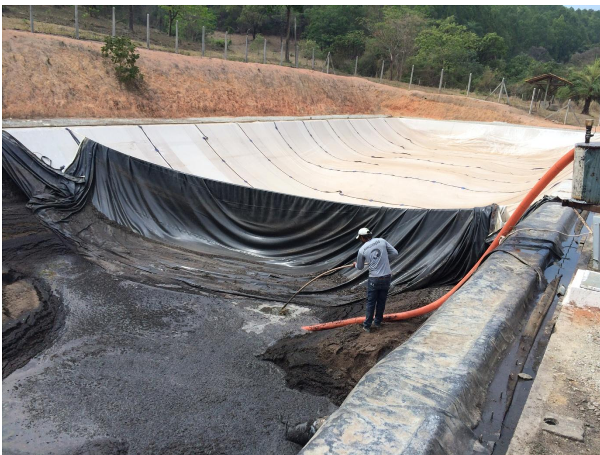
Figura 2 - Biodigestor em manutenção
