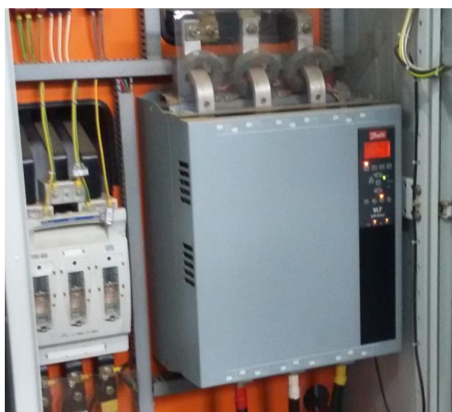
Figura 6: Painel de partida dos motores.
