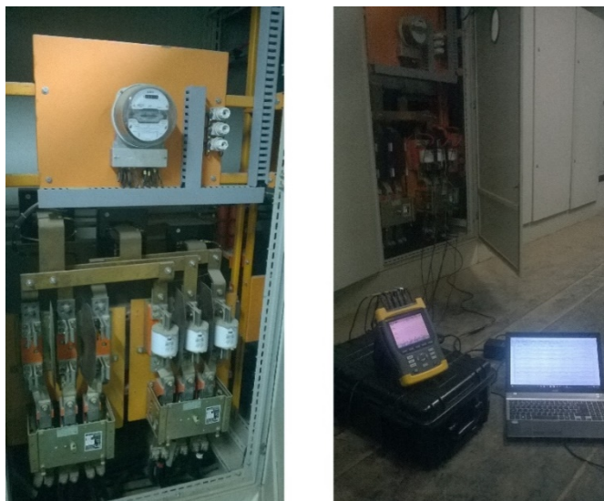
Figura 14 – Painel geral do prédio principal do Bioagro.
