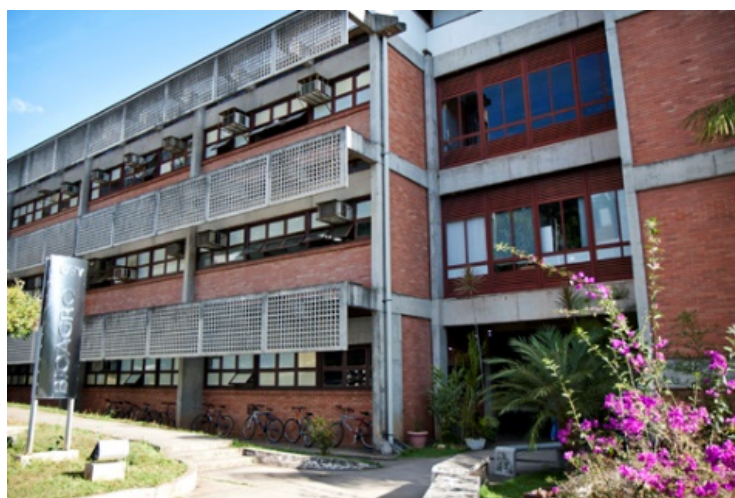
Figura 10 – Prédio Bioagro situado na Universidade Federal de Viçosa.
