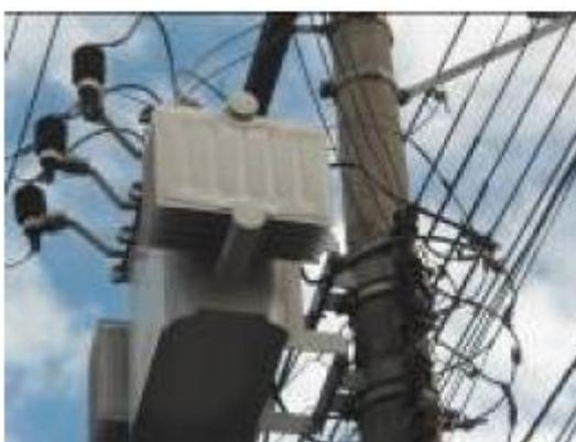
**Figura 31. Transformador novo (com para-raios agrupado).**
