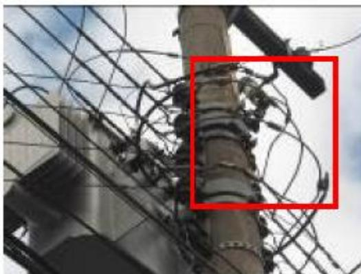
**Figura 32. Emendas nas conexões das fases, neutro e aterramento.**
