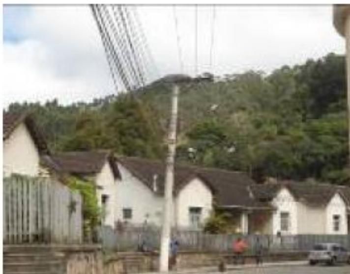
**Figura 27. Rede aérea nua de baixa tensão com cabos não tensionados.**
