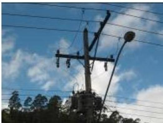
**Figura 30. Transformador substituído (sem para-raios).**
