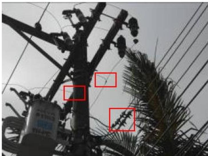
**Figura 26. Aterramento com conectores paralelo ou com emenda.**
