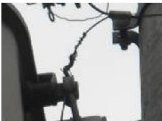
**Figura 29. Conexão do neutro para aterramento com emenda.**
