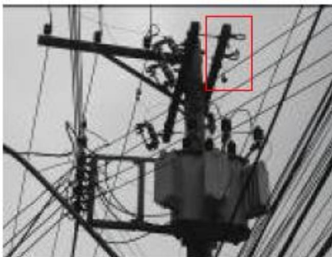
**Figura 28. Ausência de para-raios em duas fases.**
