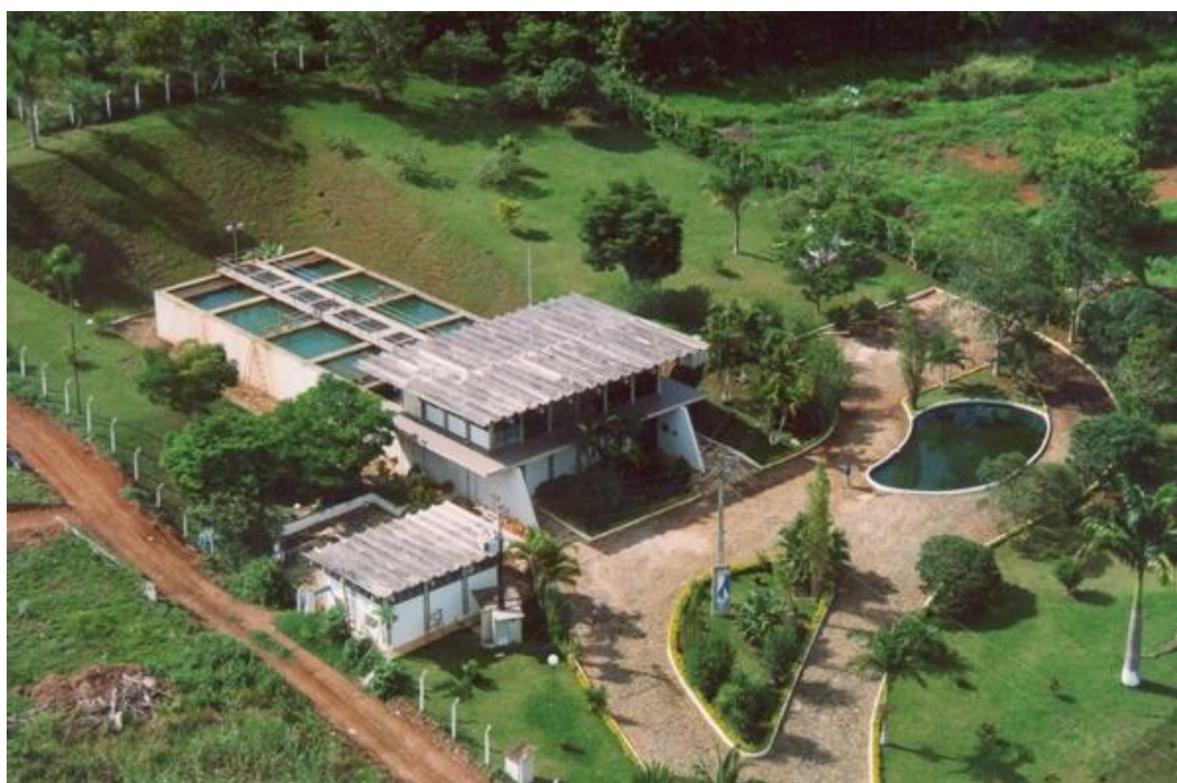
Figura 7 - ETA 2: Uma das estações de grande consumo do SAAE. Conta com área abundante e subestação própria conectada à rede de distribuição local (13,8kV).(SAAE, 2016)
