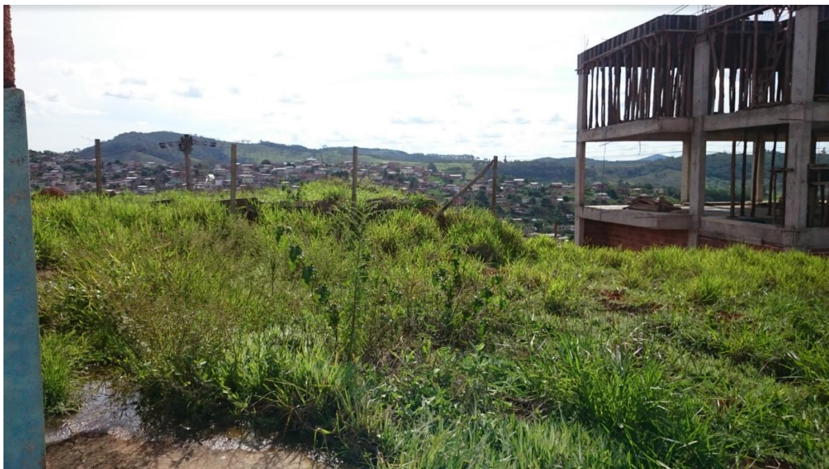
Figura 25 - Reservatório Nova Viçosa (fundos).
