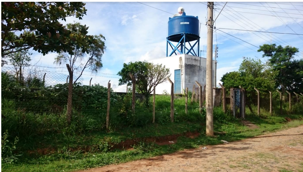
Figura 26 - Reservatório da Farinheira
