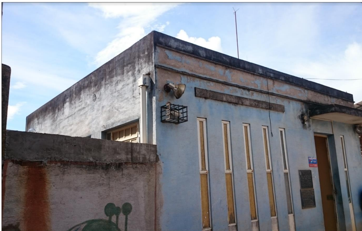
Figura 21 - Estação elevatória São José do Triunfo.
