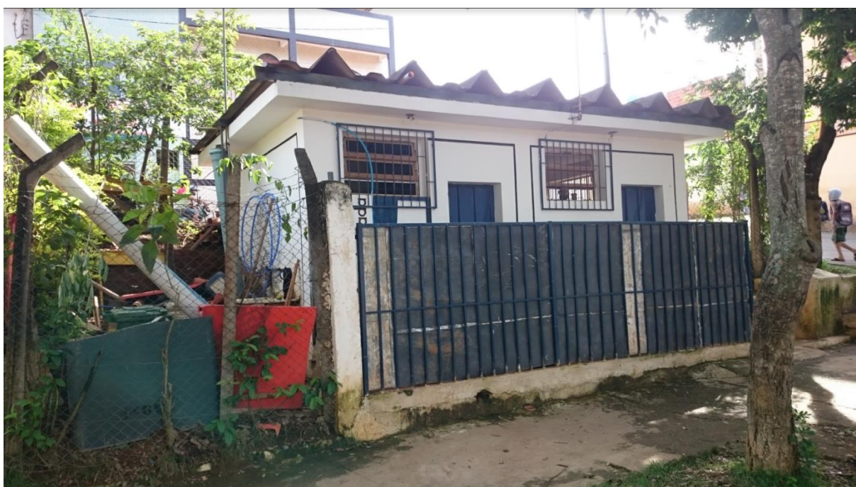
Figura 27 - Casa de máquinas do Booster Nova Viçosa.
