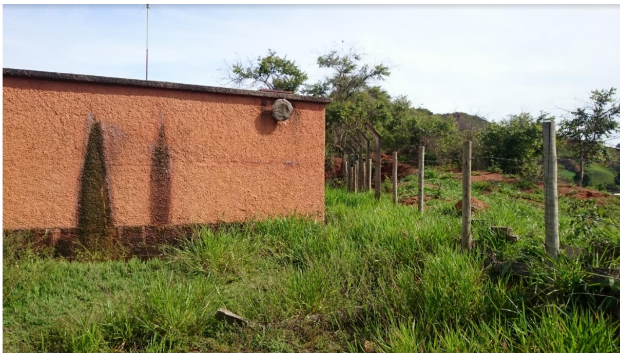
Figura 23 - Reservatório Nova Viçosa
