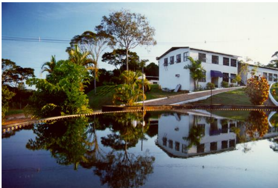
Figura 6 - Tanque de decantação na ETA 1. (SAAE, 2016)
