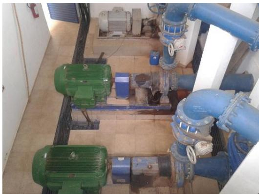
Figura 12 - Bombeamento ETA II para caixa d'água.
