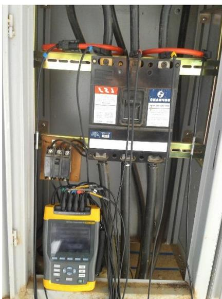
Figura 16 - Medição no barramento da ETA II
