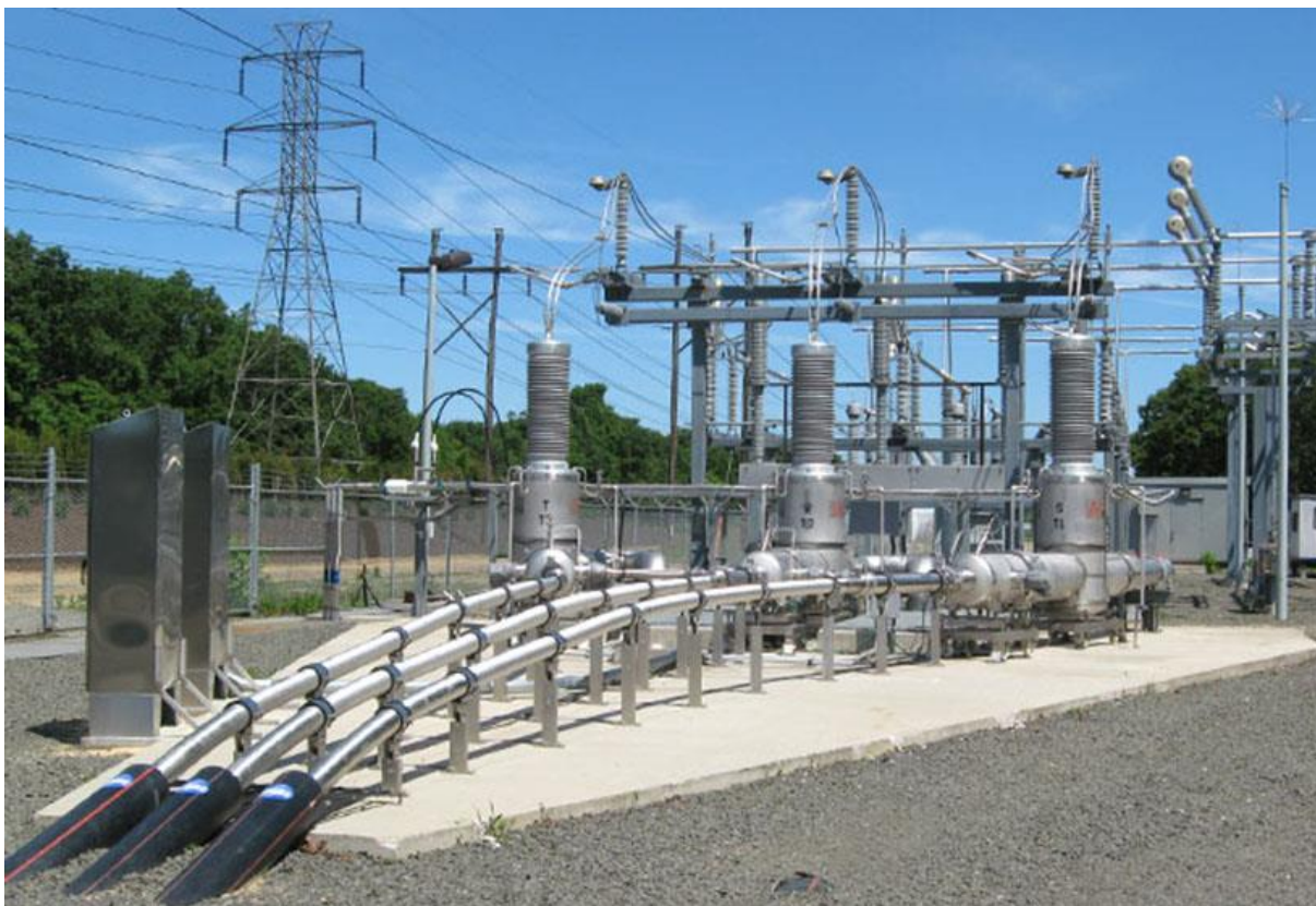
Figura 8 - Subestação de Holbrook. É considerada a primeira instalação de cabos SAT subterrânea do mundo.
