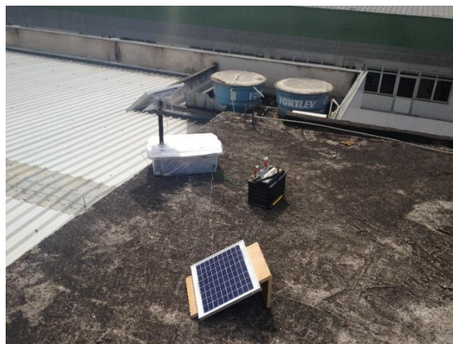
Figura 17 – Instalação do Protótipo.
