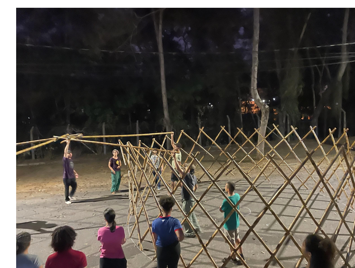
Figura 6: Trama pronta e erguida como parede
