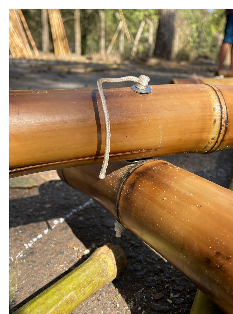
Figura 4: Amarração completa dos bambus
