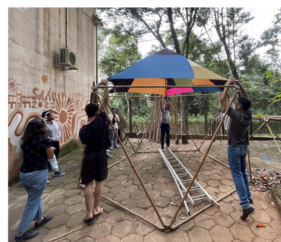
Figura 3: Geodésica V1 montada para elaboração das coberturas
