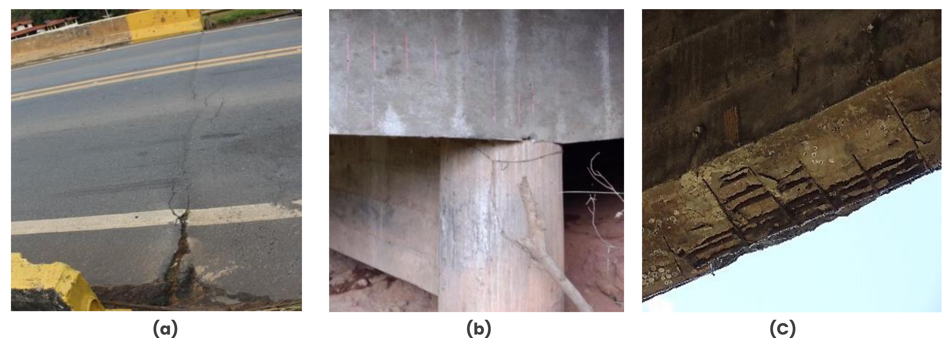
Figura 2. Manifestações Patológicas (a) Fissuração devido à ausência de junta de dilatação; (b) Aparelho de apoio não identificado; (c) Exposição e corrosão da armadura principal.
