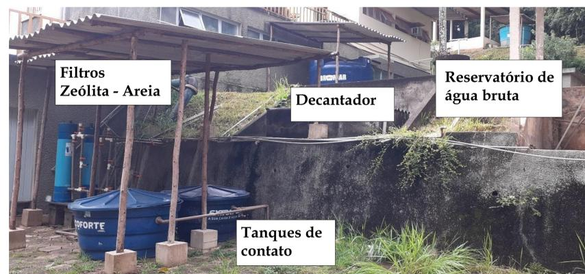
Figura 1 - Configuração da SALTA-z instalada na ETA-UFV
