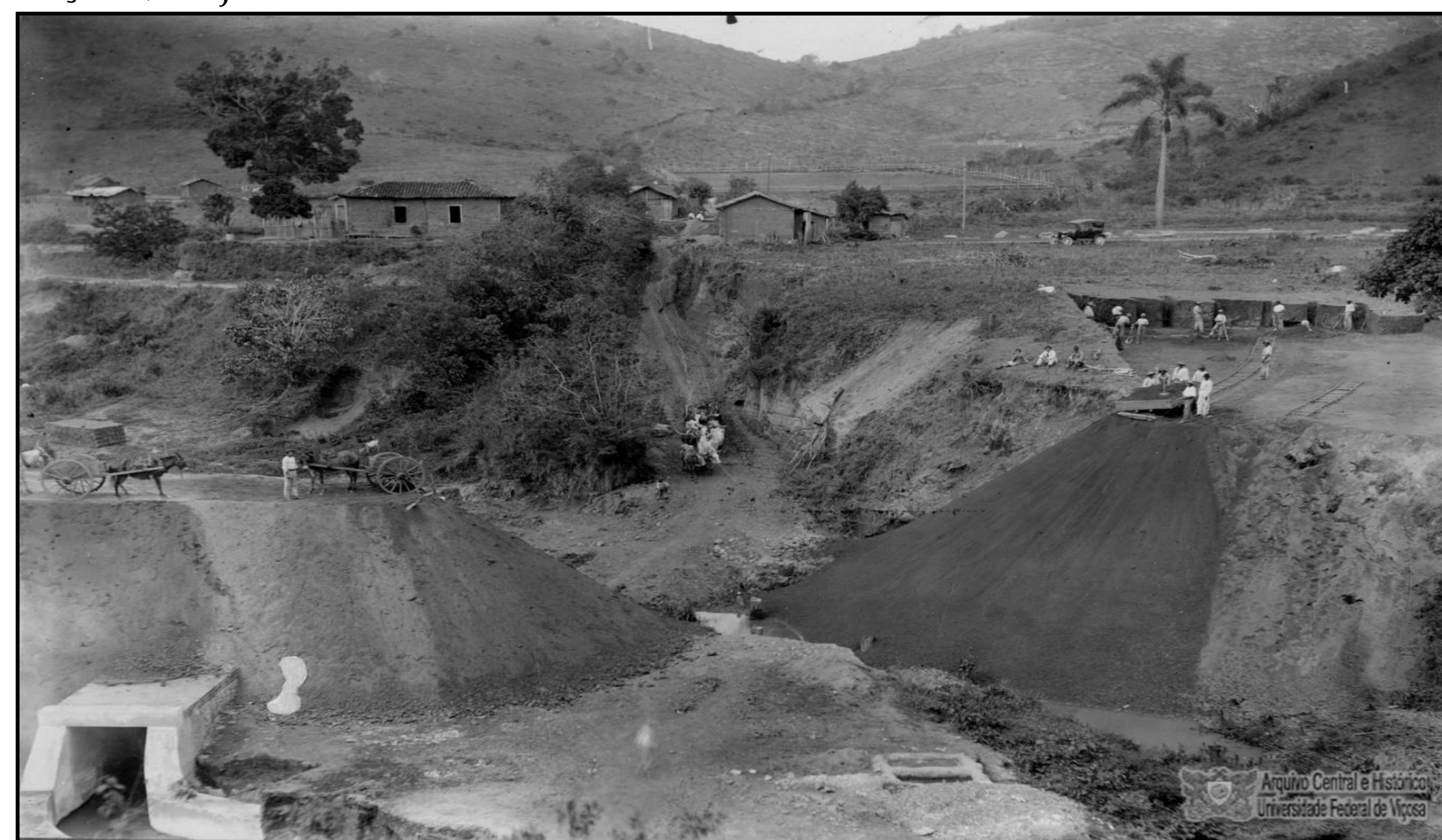
Figura 1 – Bueiro e aterro, em frente das Pilastras, para ligação com Viçosa, hoje avenida P. H. Rolfs
