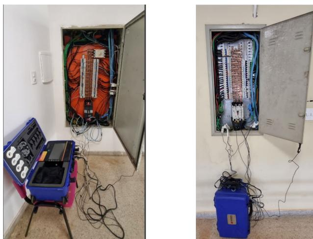
Figura 1 – Instalação do medidor (a) QGBT - Pavimento térreo (b) QDF06 - Pavimento superior.
